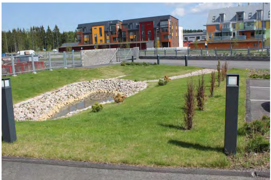
Maisemoitu hulevesikosteikko Vuoreksessa.
